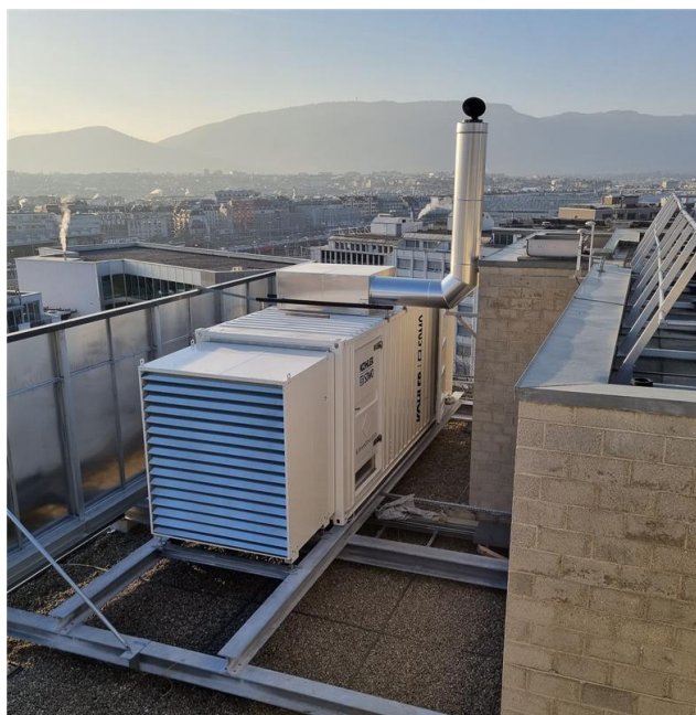
Abbildung 8: Typischer Aufbau auf Hausdach mit Dieselaggregat, Tank, Lüftung, Lärm- und Sichtschutzwand sowie Kamin.
